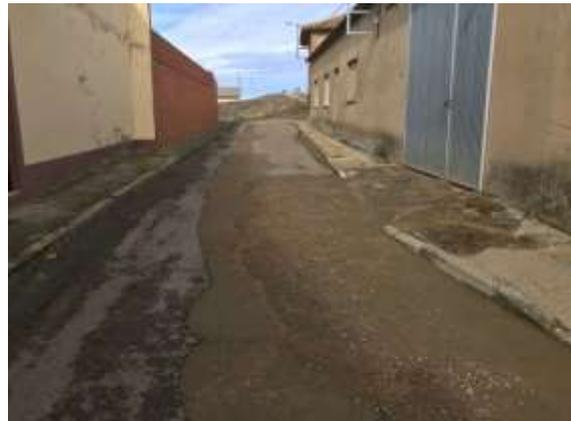
c/Las Bodegas. Se observan los asentamientos y mal estado del pavimento,
